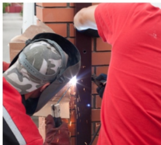
23 При помощи сварки привариваем столб к закладным (при их наличии)
