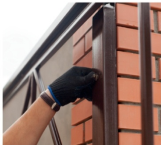
20 Закрываем отверстия пластиковыми заглушками
