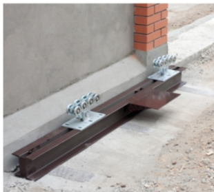
5 На балку устанавливаются роликовые опоры
