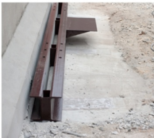
4 Опорная балка располагается параллельно ограждению
