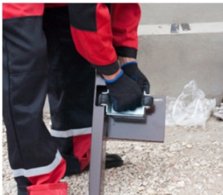
13 Устанавливаем нижний ловитель на приемный столб
