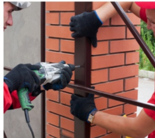
18 Просверливаем отверстия в кирпичном столбе под анкера
