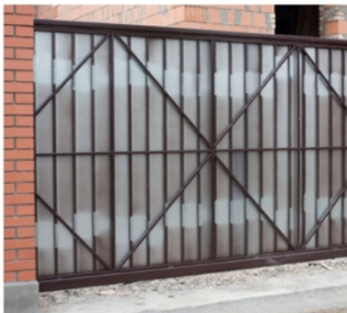
46 Обратная сторона полотна ворот зашивается аналогично первой (рис. 36-58)
