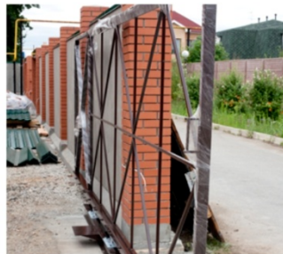
9 Определяем необходимую высоту столба от боковых качений
