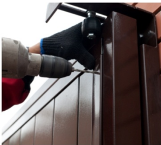
43 В доборнике необходимо просверлить отверстие
