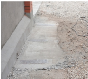
2 Закладные элементы, необходимо очистить от мусора и наплывов бетона
