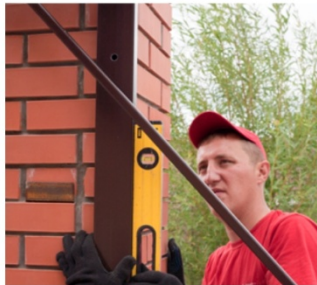
17 Выставляем столб от боковых качений вертикально с помощью уровня
