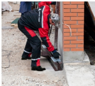
8 Накатываем полотно ворот на установленные роликовые опоры
