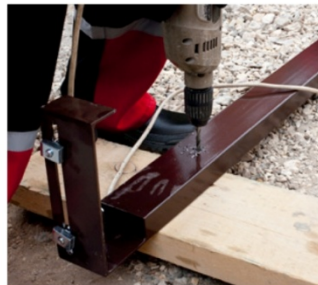
15 В столбе от бокового качения просверливаем 4 отверстия под анкеры (в комплект поставки не входят)
