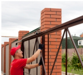
11 Расстояние от верха полотна ворот до пластины с роликами должно быть 15 мм
