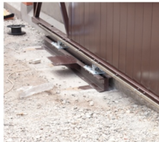
48 На площадке под привод...
