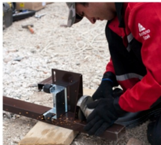
21 Укорачиваем приемный столб, при необходимости
