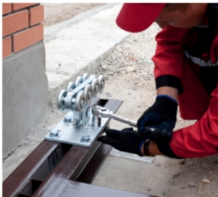
7 Протягиваем при помощи двух ключей
