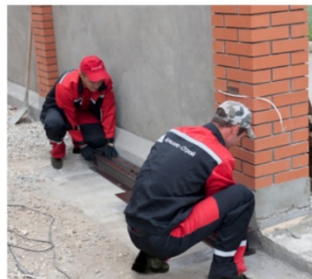
3 Устанавливаем опорную балку
