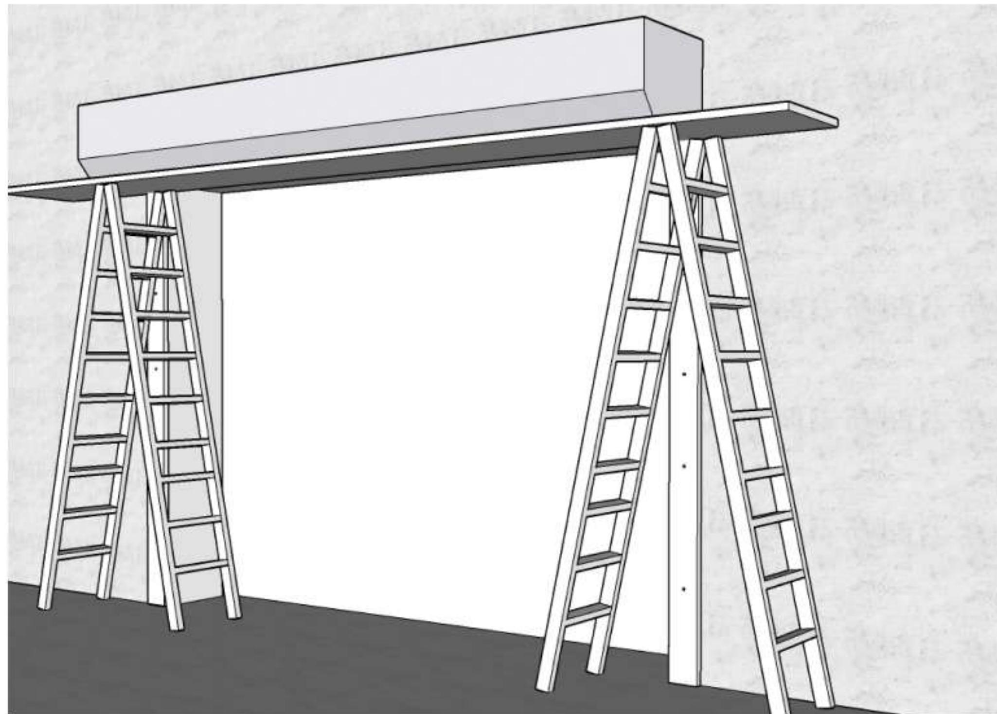
5. Постройте устойчивую монтажную площадку с помощью стремянок и деревянного бруса. Поднимите рулонные ворота на брус и установите короб в сборе
